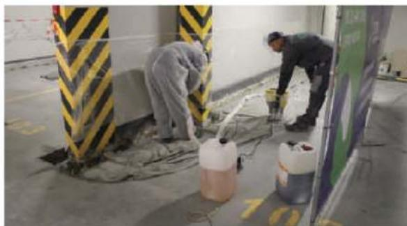
В ходе комплексного обследования паркинга было выявлено нарушение герметичности примыкания пол-стена по периметру паркинга. Произведён комплекс работ по восстановлению гидроизоляции данного узла. У заказчика появилась возможность восстановить отделку и уложиться в сроки сдачи объекта.
