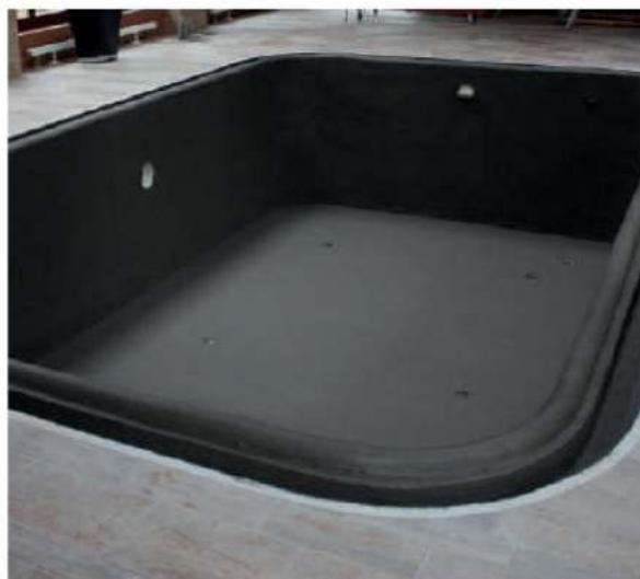
В результате проделанной работы была произведена реконструкция бассейна, восстановлена геометрия чаши с необходимыми уклонами по дну. Выполнена герметизация закладных деталей, произведено устройство специализированного эластичного гидроизоляционного покрытия PCI Seccoral 2K. Бассейн испытан и полностью подготовлен к укладке мозаики.
