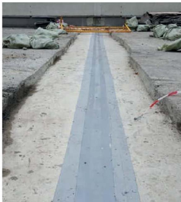
В результате проделанных работ была восстановлена герметичность деформационного шва. Применённый материал защищён от случайных повреждений защитным профилем с обеспечением необходимых степеней свободы.
