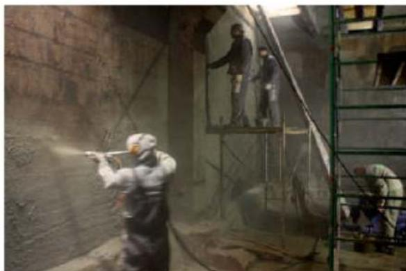
В результате проделанных работ был проведён ремонт разрушенных элементов резервуара, было выполнено устройство эластичного гидроизоляционного покрытия, пригодного для контакта с питьевой водой. Резервуар был принят санитарно-эпидемиологическим надзором.
