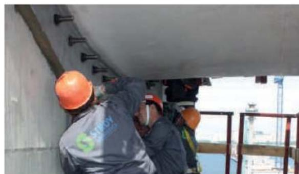
Разработан и согласован технологический регламент. Произведены работы по инъектированию зазоров между распоркой и пилоном на высоте 70 метров в стеснённых условиях. Обеспечена сплошность и монолитность примыкания распорки к пилону.
