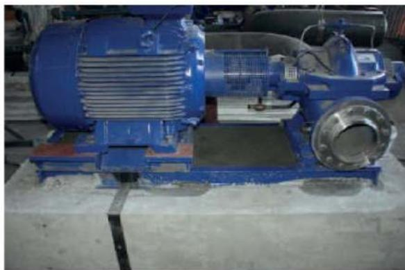
В результате проделанных работ была произведена высокоточная цементация 17 насосных рам. Залито 16м<sup>3</sup> подливочного раствора.
