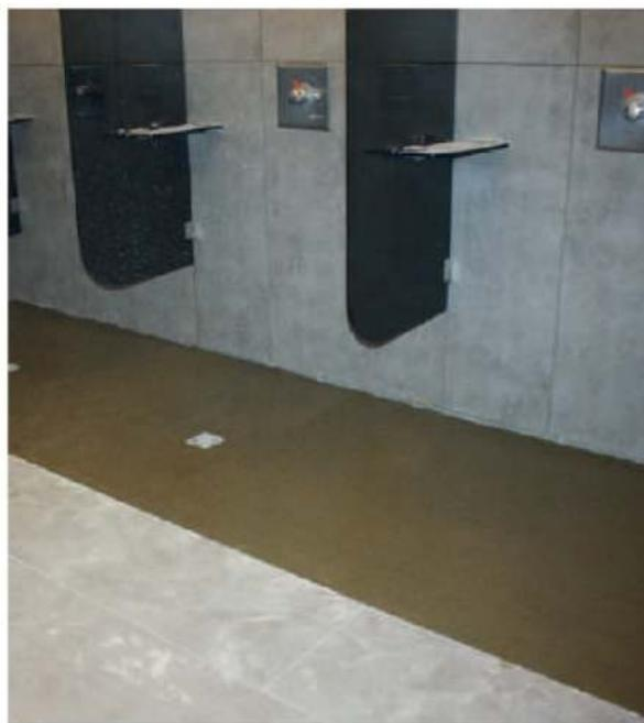
В результате за 5 дней произведена комплексная гидроизоляция 6 душевых (60 м<sup>2</sup>), комплекс открылся без задержек, дорогостоящее оборудование в технических помещениях защищено от протечек.
