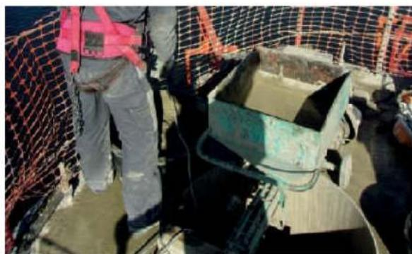
Был разработан и согласован технологический регламент по заполнению отверстий по принципу восходящего раствора. Произведены уникальные работы по заполнению отверстий на высоте 114 метров в стеснённых условиях. Заполнены 12 отверстий инъекционным составом на основе безусадочного микроцемента.
