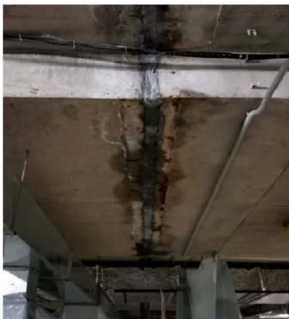
Восстановлена герметичность деформационного шва. Владельцы машиномест избавлены от протечек на свои автомобили.
