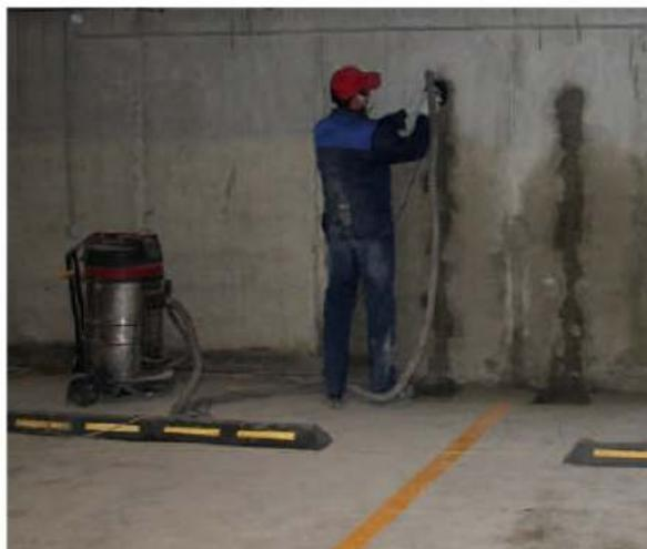
Были устранены локальные протечки, трещины заполнены инъекционной смолой, что исключает развитие коррозии рабочей арматуры. Работы по отделке паркинга продолжены в штатном режиме.
