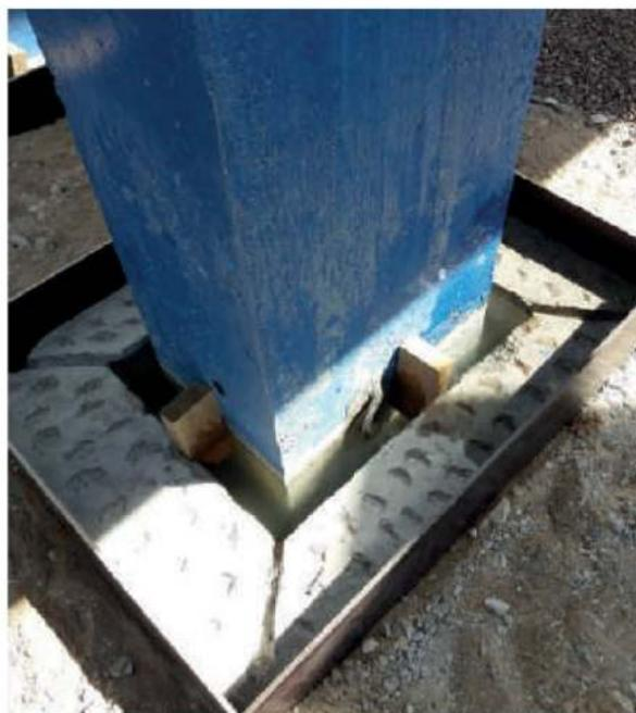
В результате проделанных работ была разработана технология демонтажа чеканочного раствора без разборки конструкции фундамента. В ограниченные сроки был выполнен ремонт 179 фундаментов.
