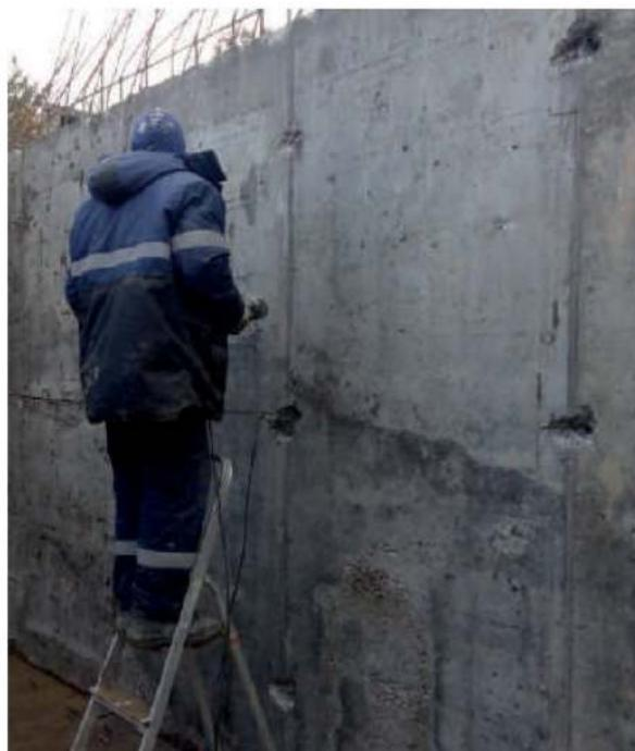
В результате проведённых работ была обеспечена герметичность резервуара. Резервуар прошёл гидроиспытания и принят к эксплуатации.
