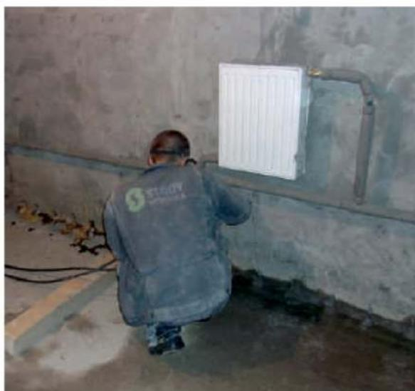
В результате проделанных работ были устранены дефекты бетонирования и выполнена внутренняя гидроизоляция подвального помещения.
