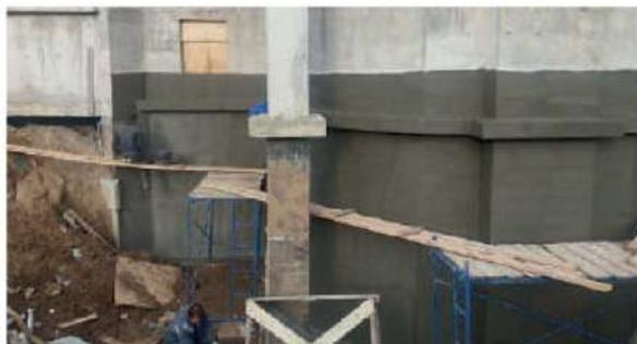
В результате проведённых работ произведена качественная внешняя гидроизоляция подземной части здания. Исправлены допущенные ранее ошибки. Работы по отделке продолжены.
