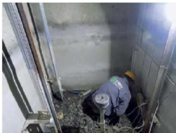
В результате проделанных работ был выполнен комплекс работ обеспечивающий надёжную гидроизоляцию лифтового приямка, позволивший продолжить работы по монтажу лифтового оборудования.
