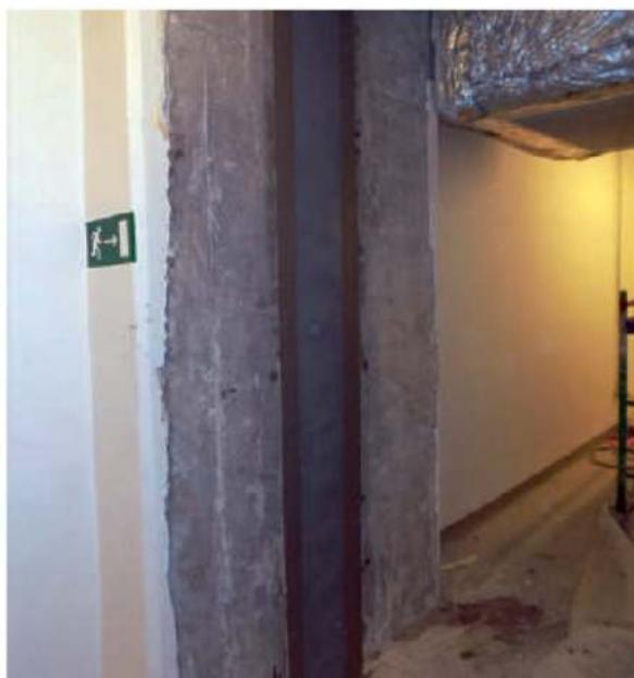
В результате проделанных работ была восстановлена герметичность деформационного шва. Примененный материал защищен от случайных повреждений защитной пластиной с обеспечением необходимых степеней свободы.
