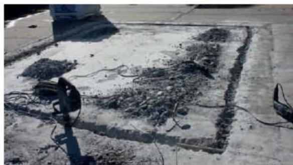
За счёт коэффициента расширения ремонтного состава была восстановлена монолитность плиты перекрытия. В ходе инъекционных работ была произведена герметизация шва ригеля с полным заполнением имеющихся пустот и дефектов в зоне холодного шва ремонтной эпоксидной смолой, что обеспечило ремонт ригеля по всему сечению. Конструкции были приняты техническим надзором и строительство продолжилось.
