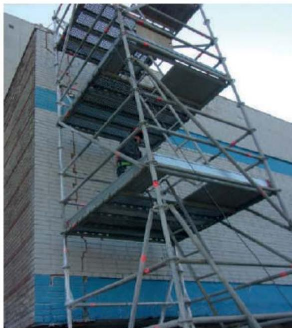
В результате проделанных работ был произведён ремонт трещин на кирпичном фасаде здания методом структурного склеивания. Удалось избежать установки металлических хомутов и сохранить архитектурный вид.
