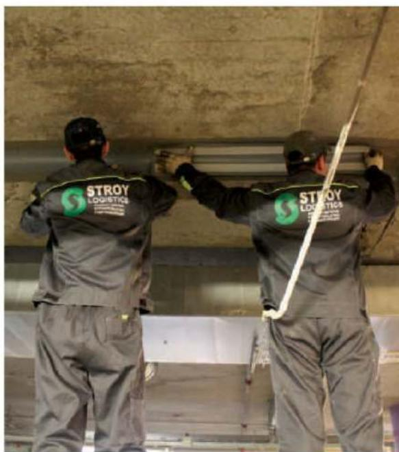
Была восстановлена гидроизоляция деформационного шва в плите перекрытия двухуровневого паркинга. Решена насущная проблема протечек талого снега с верхнего уровня на нижний.
