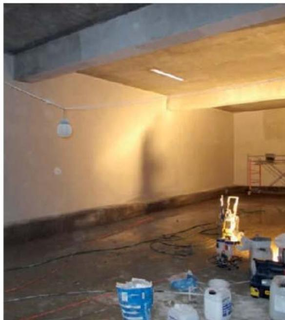
В результате проведённых работ была восстановлена герметичность резервуаров. Резервуары прошли испытания и приняты к эксплуатации.
